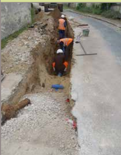
Travaux eau potable Boissy-aux-Cailles
