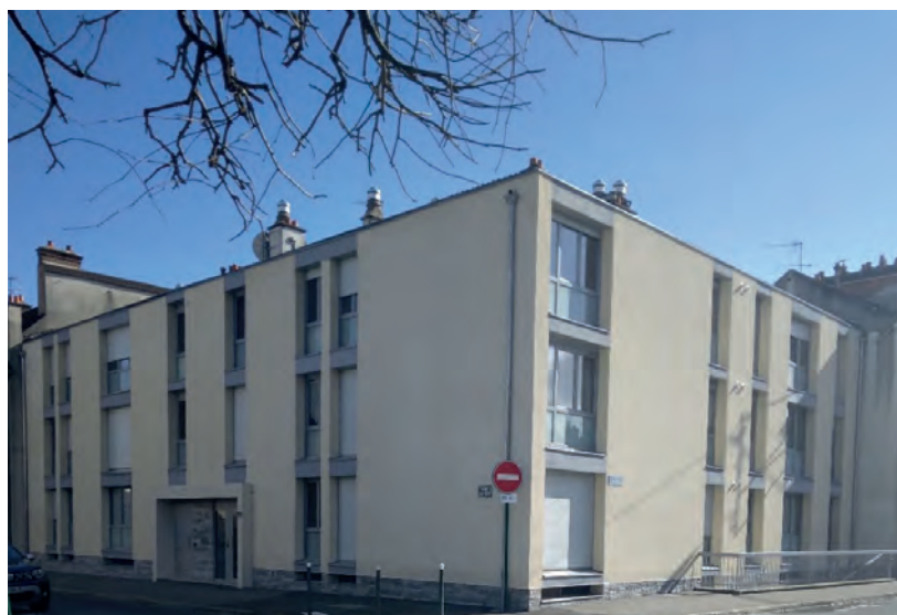
→ Réhabilitation de logements
