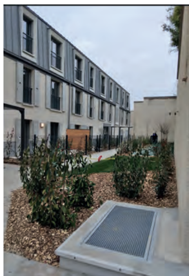
→ Travaux rue Lagorsse
