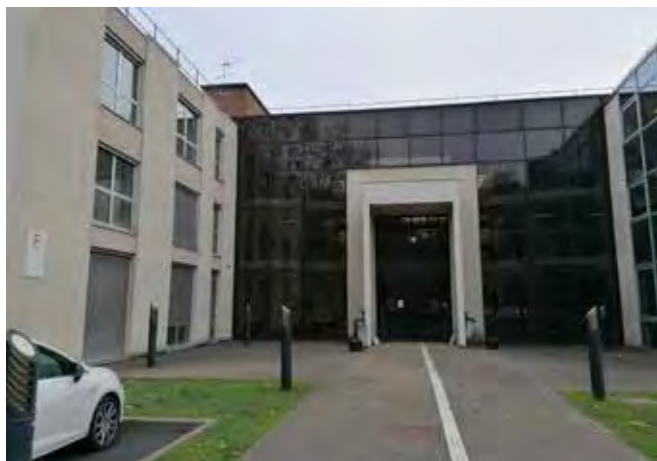
7 lots travaux pour les futurs locaux
