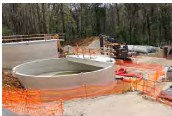
Construction de la STEP de Saint-Sauveur-sur-École
