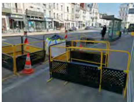
Travaux préalables Place de l'Étape
