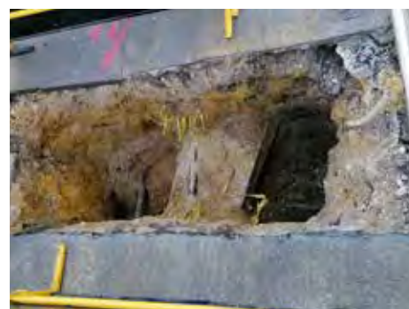
Travaux préalables Place de l'Étape
