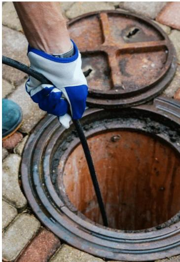
La société ORTEC va intervenir pour effectuer un curage préventif des réseaux dans plusieurs rues de la commune. Ces opérations permettent de nettoyer les canalisations pour éliminer dépôts et obstructions, assurer un bon écoulement et prévenir les bouchons et inondations.
