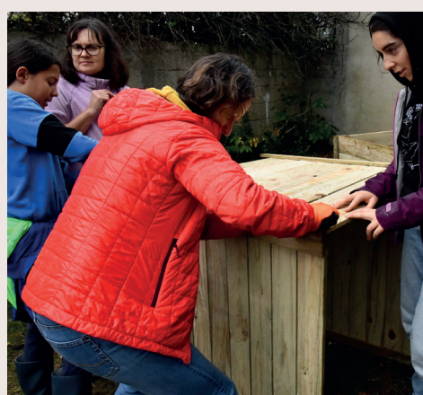
↑ INSTALLATION D'UN BAC À COMPOST DANS LE QUARTIER DE LA PLAINE DE LA CHAMBRE
