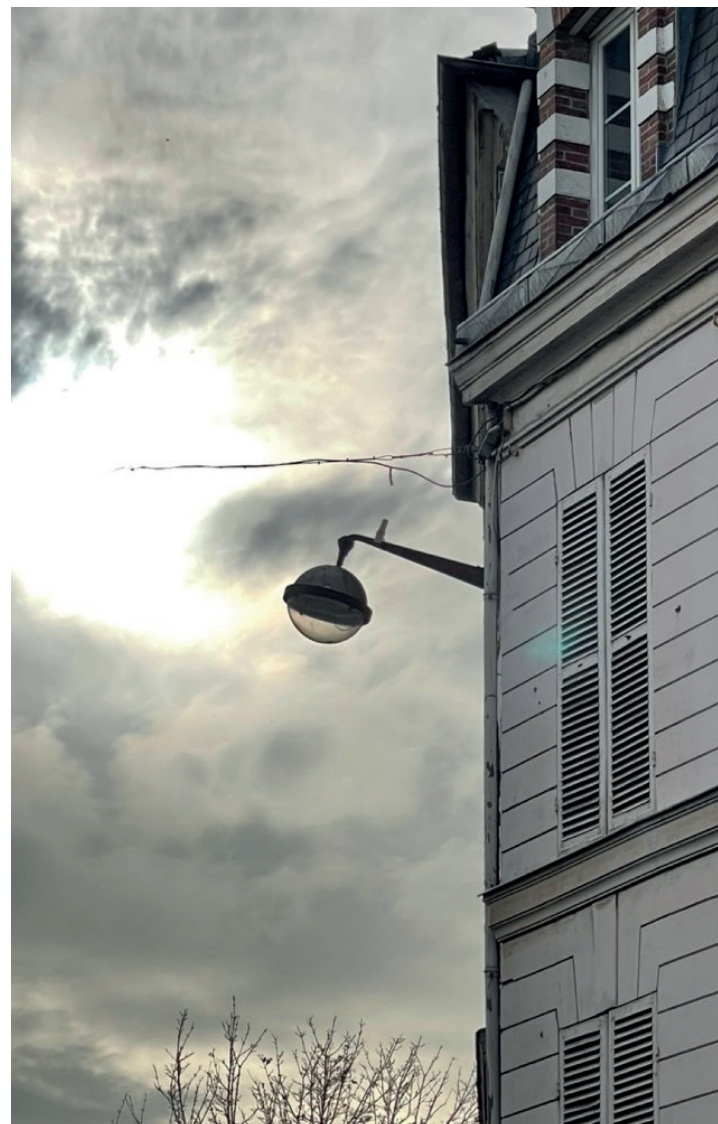
↑ CONVERSION DE L'ÉCLAIRAGE EN LED (AVANT/APRÈS)
