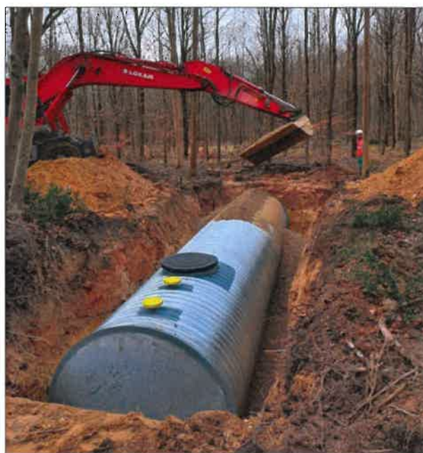
Installation d'une citerne enterrée © ONF (2022)
