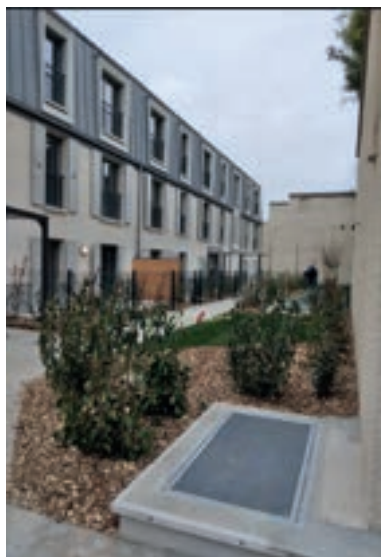
→ Travaux rue Lagorsse
