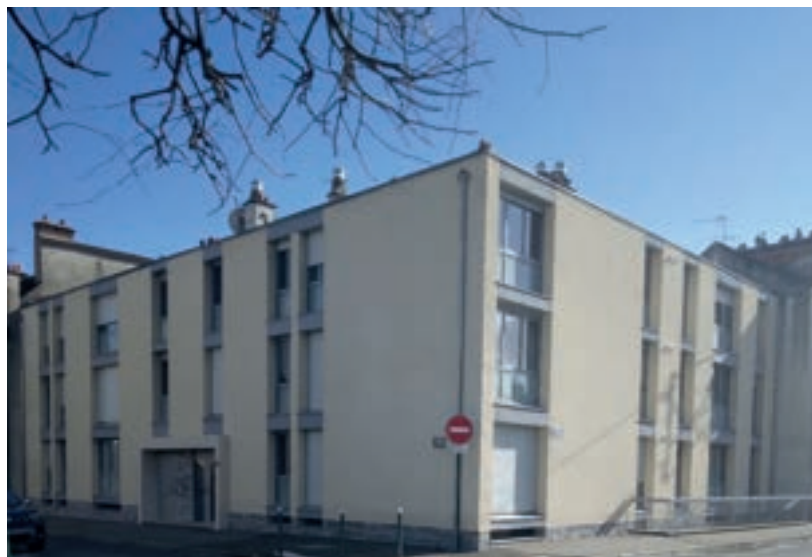
→ Réhabilitation de logements
