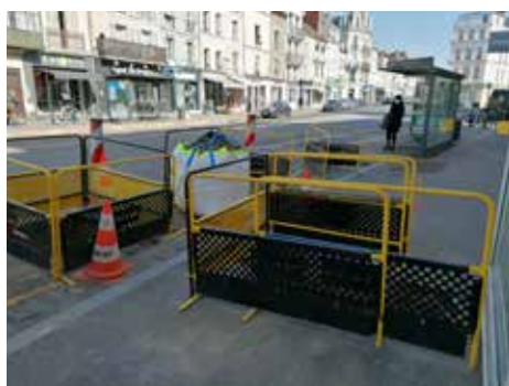
Travaux préalables Place de l'Étape
