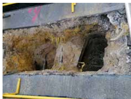
Travaux préalables Place de l'Étape
