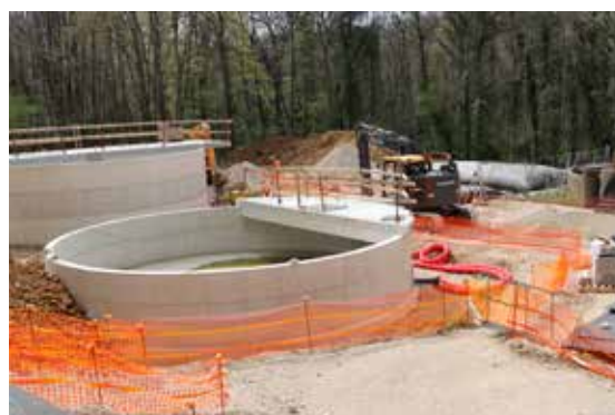
Construction de la STEP de Saint-Sauveur-sur-École
