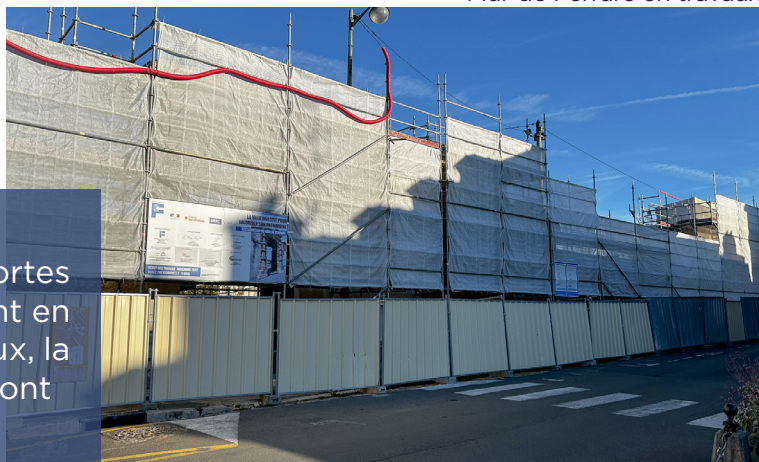
Mur de Ferrare en travaux
