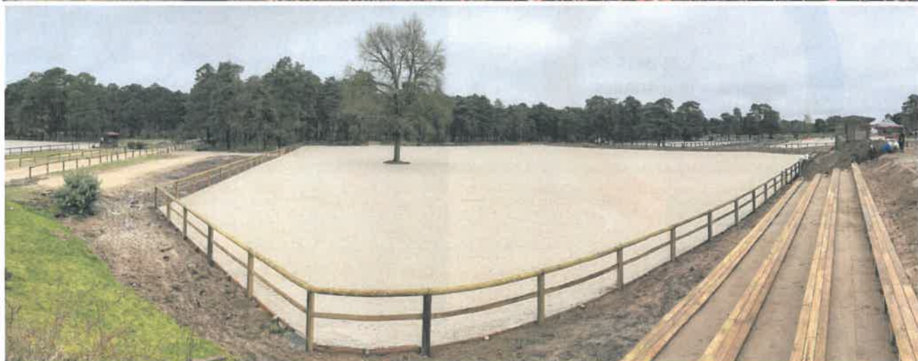
Le Petit Parquet pendant et après les travaux
