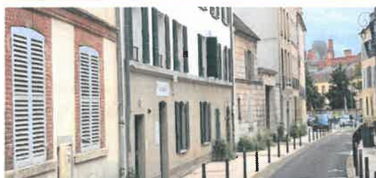
Réhabilitation de logements Rue du Château / Fontainebleau
