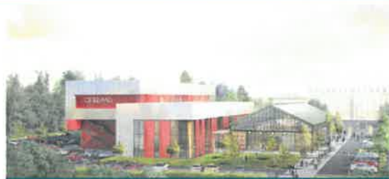
Complexe de loisirs Les Halles de Villars / Fontainebleau
