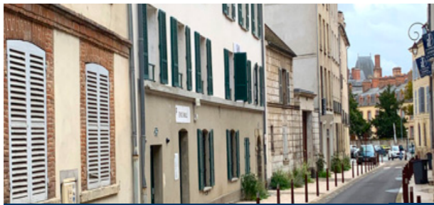
Réhabilitation de logements Rue du Château / Fontainebleau
