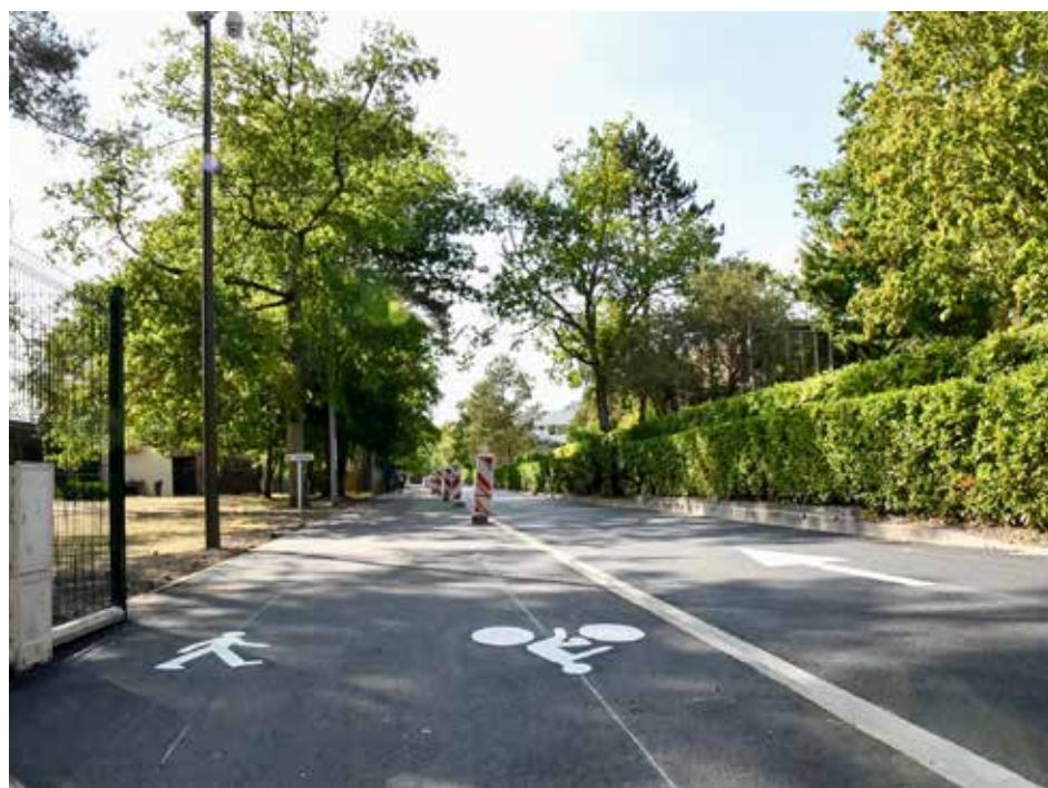
↑ LA ROUTE DE L'ERMITAGE APRÈS TRAVAUX
